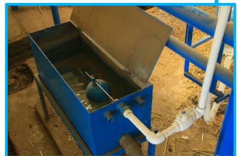
Solche Schwimmerbehälter und deren Abgangsleitungen sind mindestens wöchentlich zu reinigen und zu spülen. Foto KFM
